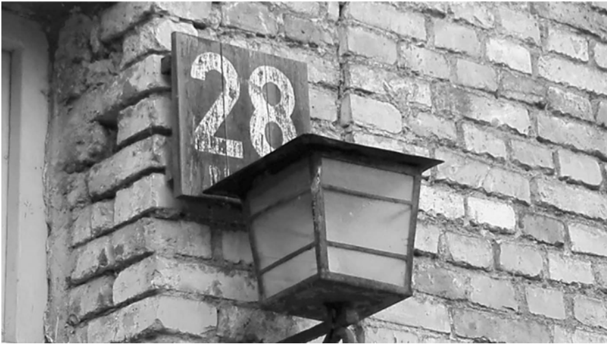
Abb. 5: Eingangstür zum Block 28. Foto: Ehlert
